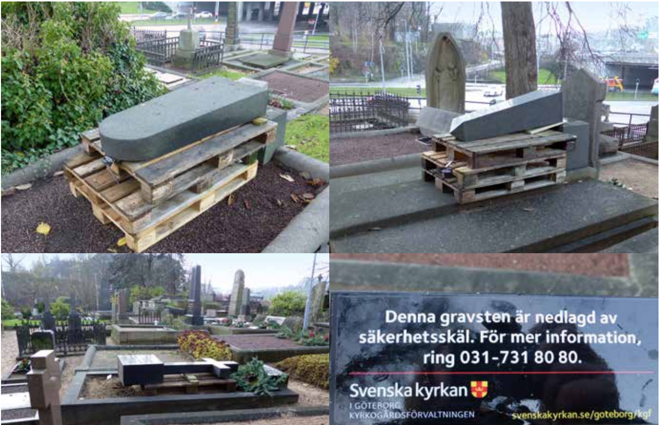
Efter dødsulykken på kirkegården i Bollebygd, blev arbejdet med at sikre gravminderne på de svenske kirkegårde sat i system. Eksempler fra Ørgryste Gamle Kirkegård i Gøteborg.
